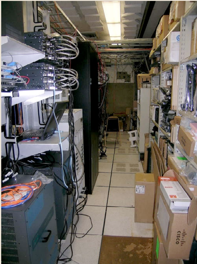
L7 Server Aisle
